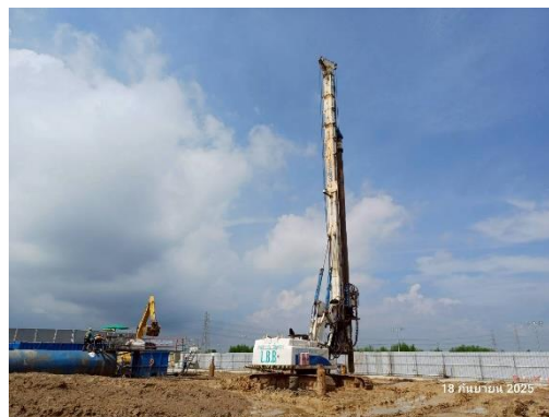
รูปที่ 2-43 วิธีเจาะส่วนำก่อนตอก (Pre-bore)
